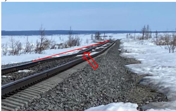
Рис. 1. Характерные деформации участка железной дороги на 167 км перегона Чум – Лабытнанги: а – термопросадка железнодорожного пути из-за деградации ММГ; б – пучины железнодорожного пути из-за сезонного промерзания грунтов основания
