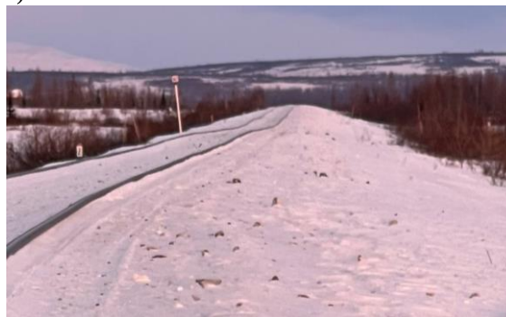
Рис. 1. Характерные деформации участка железной дороги на 167 км перегона Чум – Лабытнанги: а – термопросадка железнодорожного пути из-за деградации ММГ; б – пучины железнодорожного пути из-за сезонного промерзания грунтов основания
