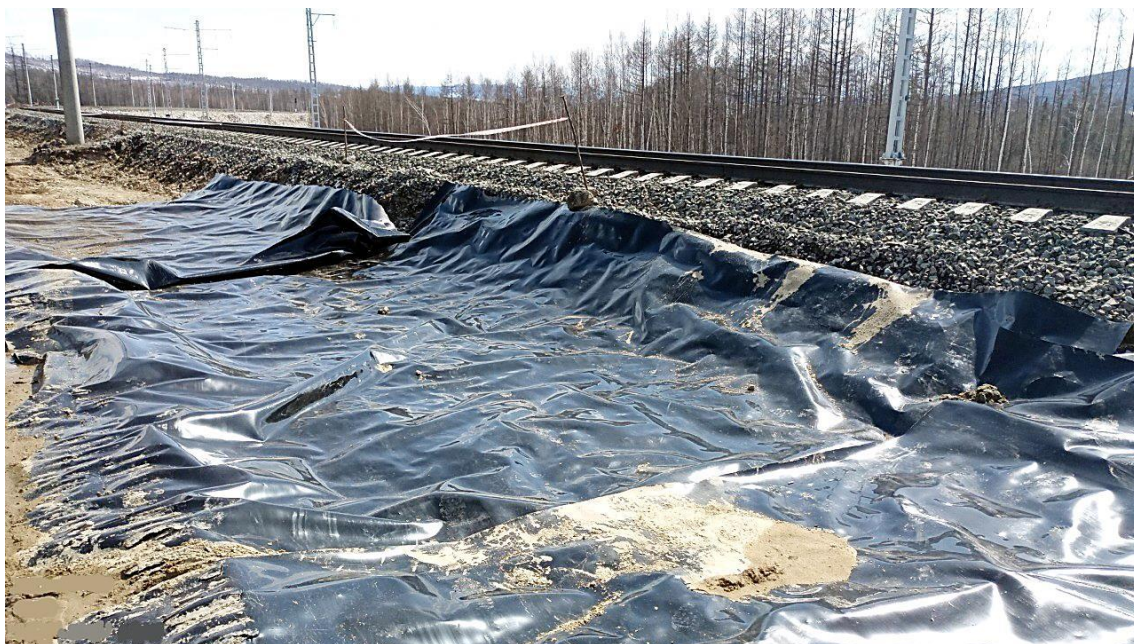
Рис. 12. Геомембрана с двусторонним термоскрепленным геотекстилем на БАМе
