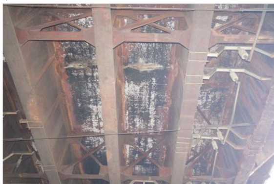
Рис. 9. Повреждения пролетного строения: а – выщелачивание цементного камня на нижней поверхности плиты путепровода; б – коррозия верхних поясных уголков путепровода
