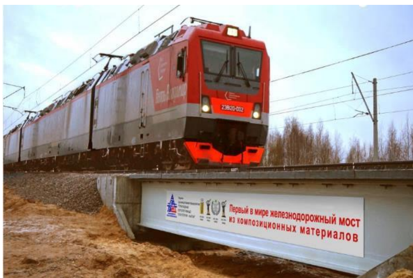
Рис. 5. Первый в мире цельнокомпозитный железнодорожный мост [5]
