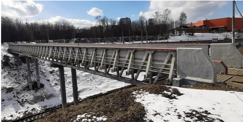
Рис. 3. Первый в России мост с цельнокомпозитным пролетом
