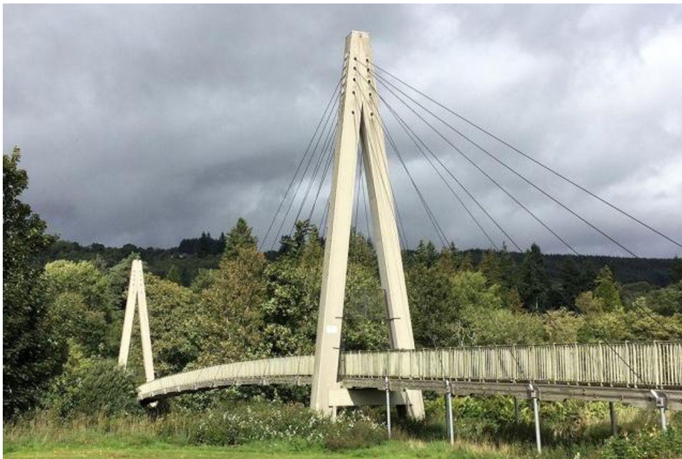
Рис. 1. Пешеходный мост в Аберфельди [2]
