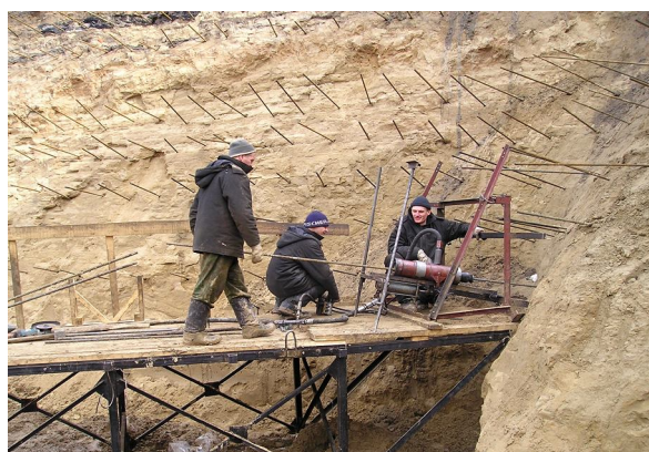
Рис. 3. Закрепление откоса стержнями на ул. Восход в г. Новосибирске
