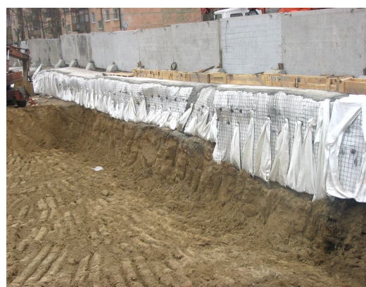
Рис. 3. Закрепление откоса стержнями на ул. Восход в г. Новосибирске
