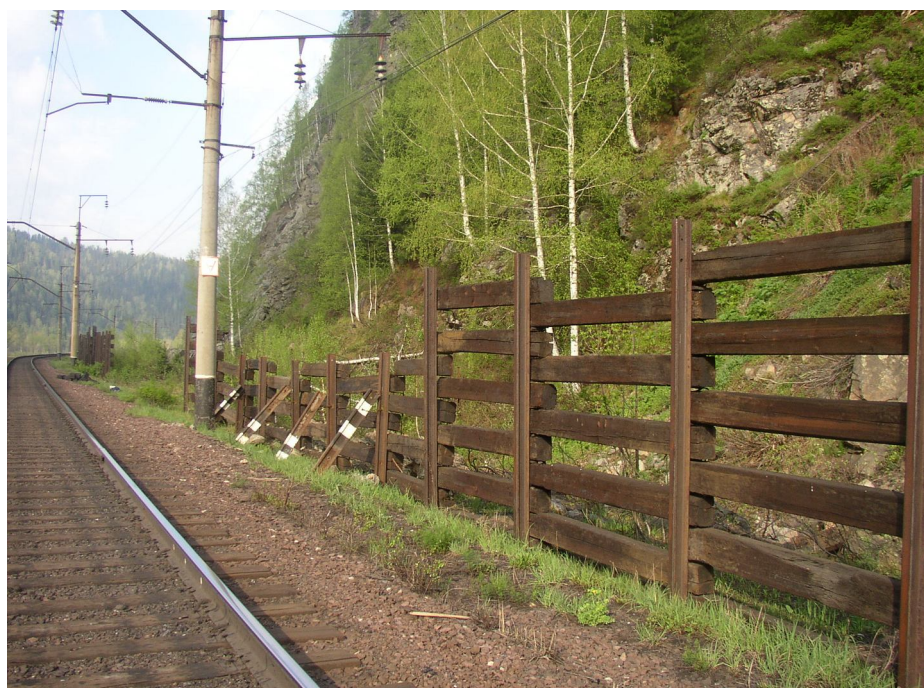
Рис. 3. Лавинонаправляющая стенка
