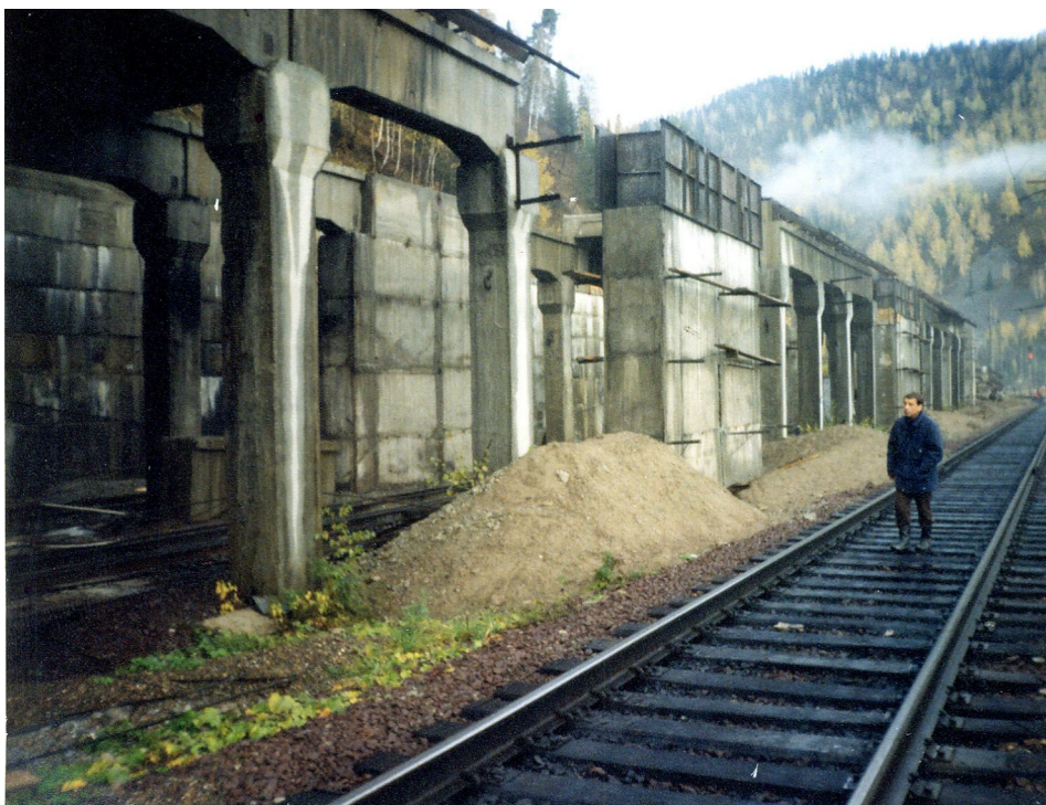
Рис. 5. Строительство лавинозащитной галереи на 133-м км
