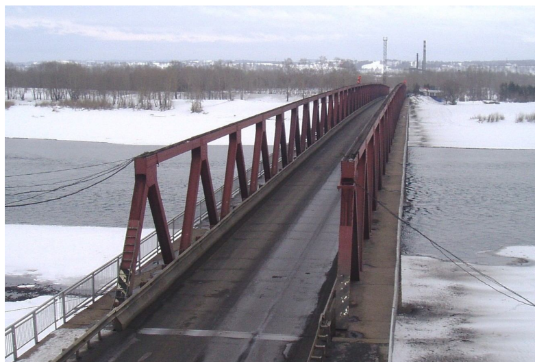
Рис. 1. Вид на мост по ходу километража
