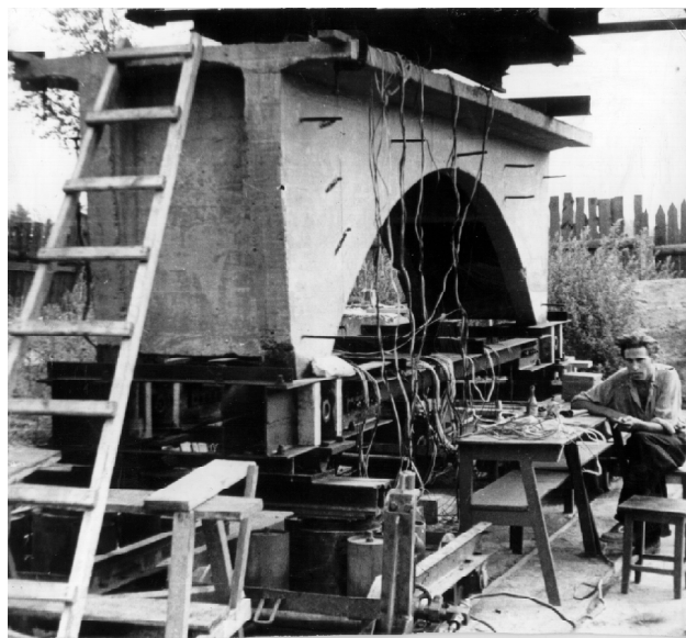
Испытание модели пролетного строения с дисковыми арками
