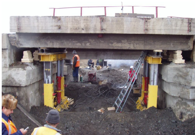
Подъемка пролетного строения с использованием технологического комплекса, разработанного в ЛМК
