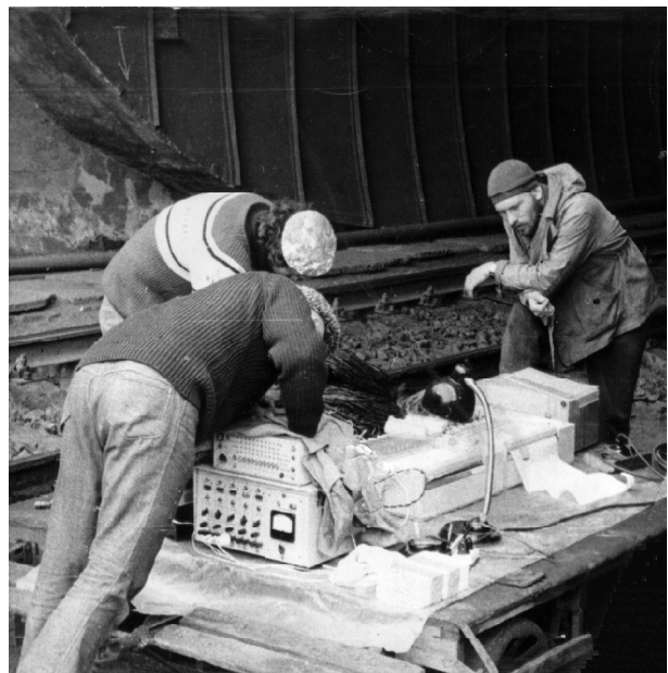
Исследовательские работы в тоннеле
