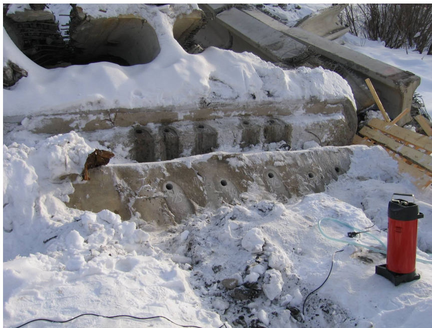
Рис. 8. Места отбора кернов из опоры № 2 (контурный блок № 7, бетон ядра заполнения в уровне блока № 7)
