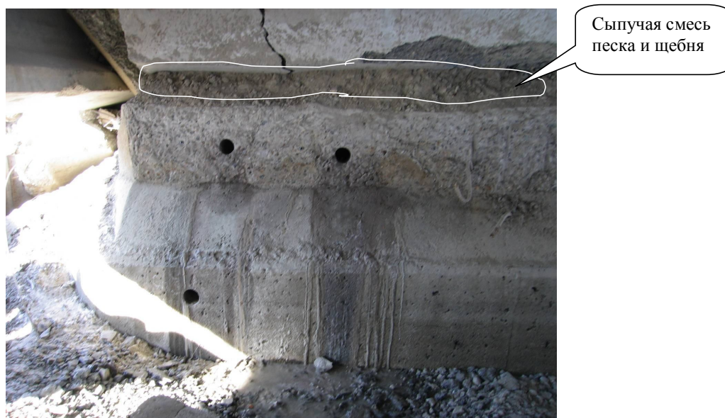
Рис. 7. Места отбора кернов из опоры № 3 (контурный блок № 2, бетон ядра заполнения в уровне блока № 3)
