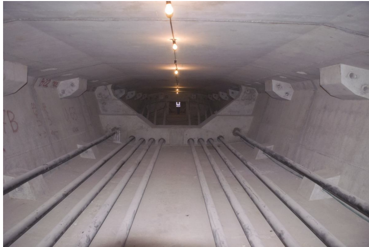
Рис. 3. Внешняя преднапрягаемая арматура
