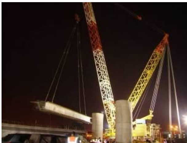
Рис. 4. Монтаж сборного элемента
