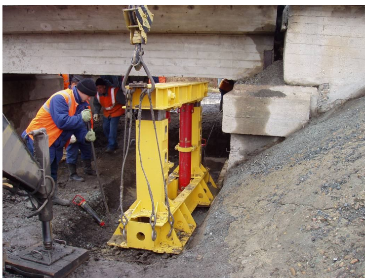
Рис. 4. Установка универсальных опор-рам под пролет
