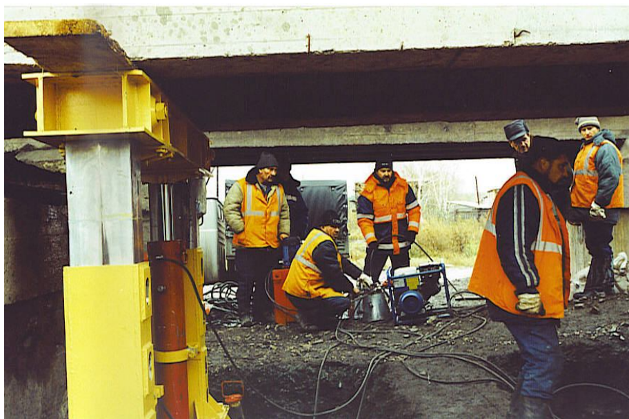
Рис. 6. Подключение и проверка работы гидравлического оборудования
