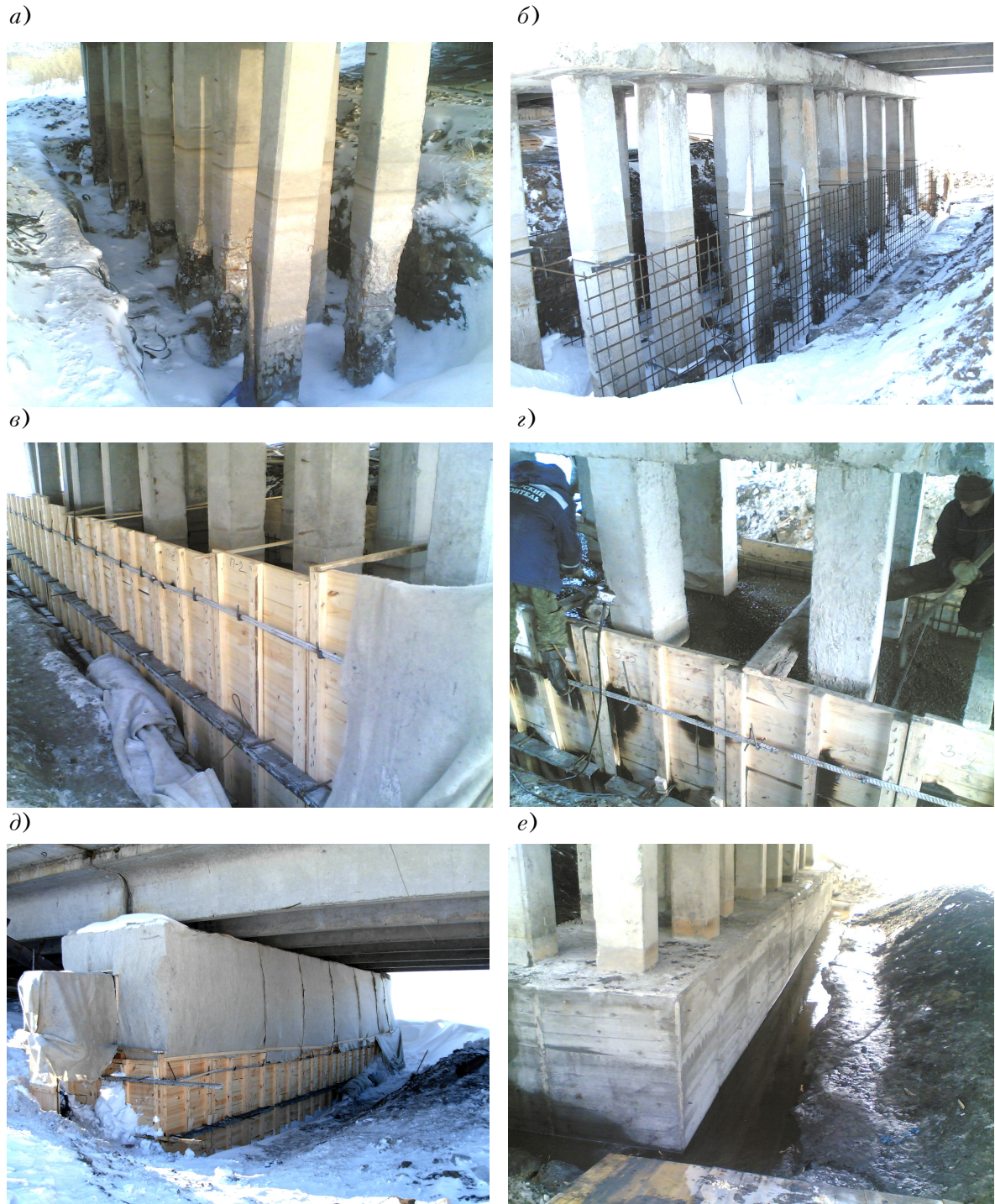
Рис. 3. Усиление свай стоечной опоры моста через р. Кама объединяющим железобетонным бандажом:
