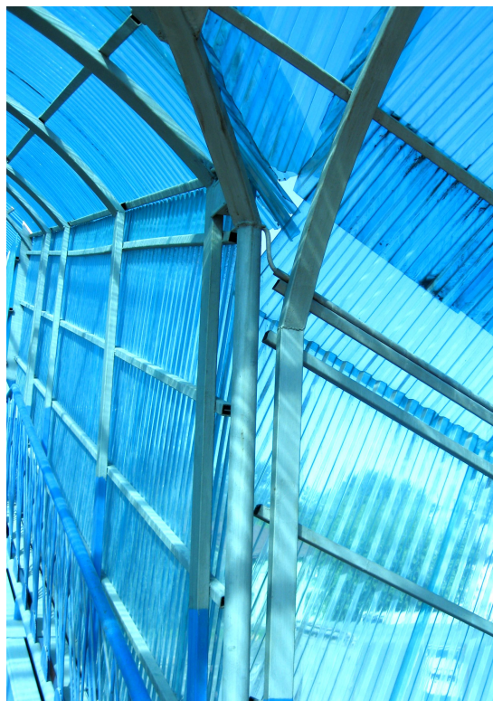
Рис. 4. Взаимное расположение элементов ограждения на повороте лестницы: а — покрытие из поликарбоната; б — покрытие из ондекса
