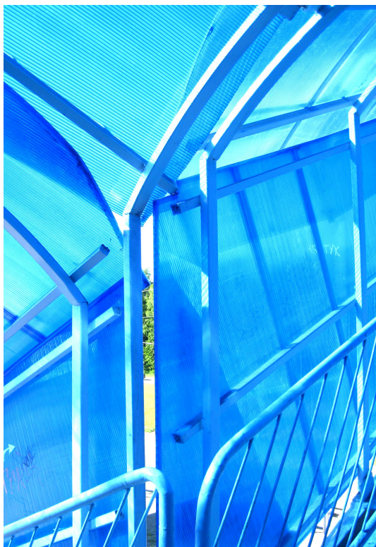
Рис. 4. Взаимное расположение элементов ограждения на повороте лестницы: а — покрытие из поликарбоната; б — покрытие из ондекса
