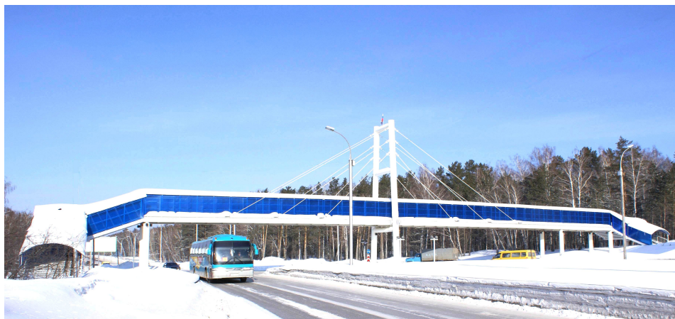
Рис. 2. Вантовый пешеходный мост через Бердское шоссе в створе Морского проспекта Академгородка
