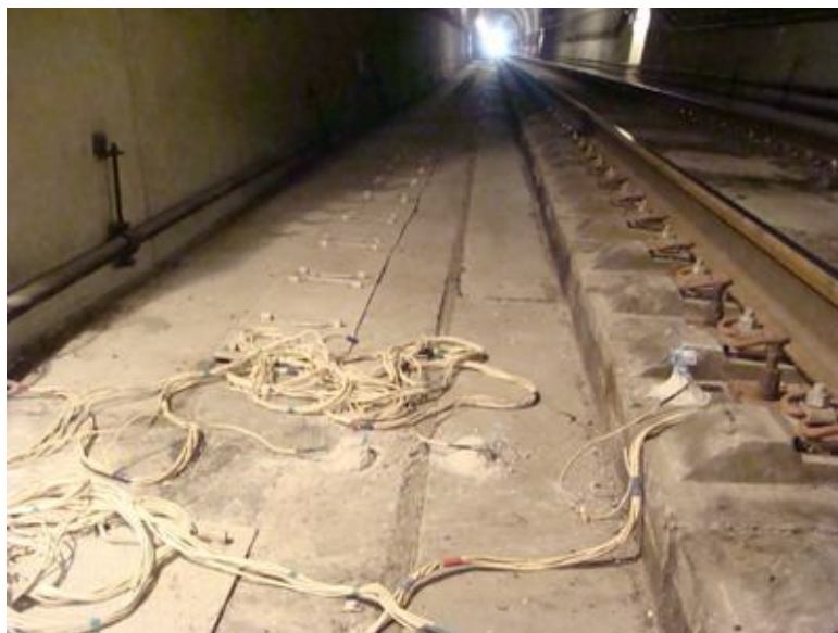
Рис. 4. Установка сейсмоприемников на раме, путевом бетоне и стенке водоотводного лотка
