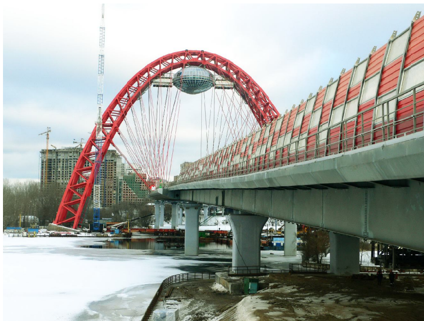
Рис. 2. Общий вид моста со стороны левобережной эстакады
