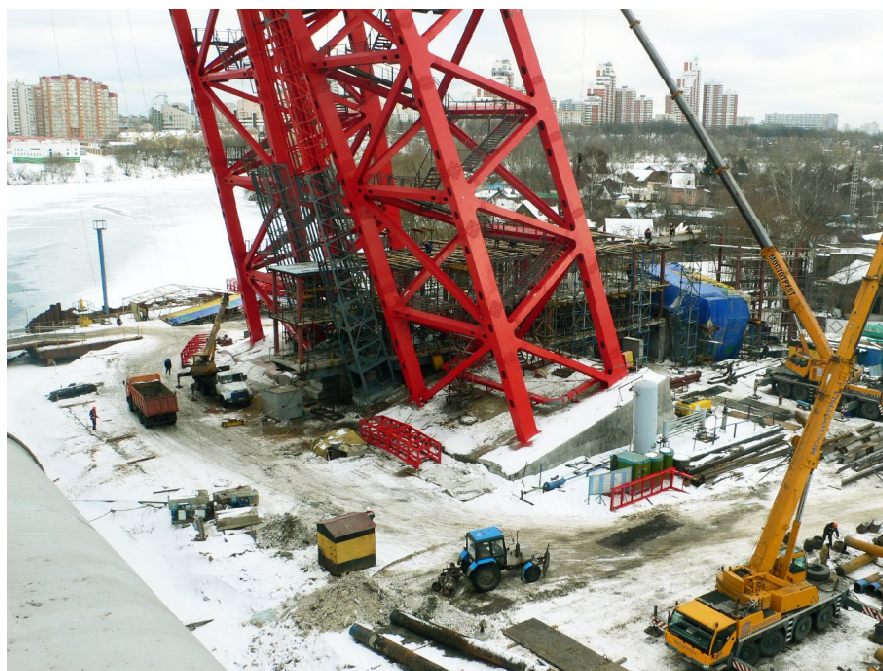
Рис. 3. Вид левобережной арочной опоры в процессе строительства
