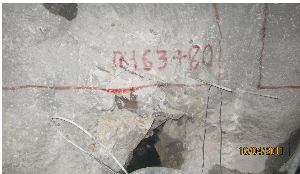
Рис. 6. Выход карста в ЖДТ ПК 163+80 в месте проектного расположения людской ниши
