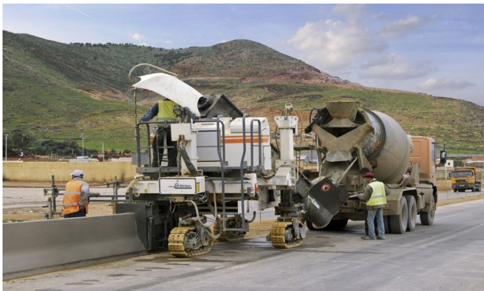
Рис. 3. Процесс устройства монолитного ограждения при помощи бетоноукладчика Wirtgen SP 25
