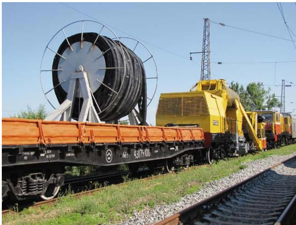
Рис. 2. Общий вид укладочного комплекса на базе машины СЧ-601
