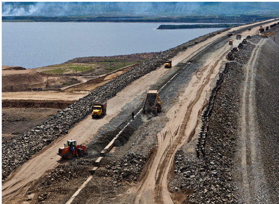
Рис. 2. Отсыпка пойменной насыпи и укрепление откосов каменной наброской
