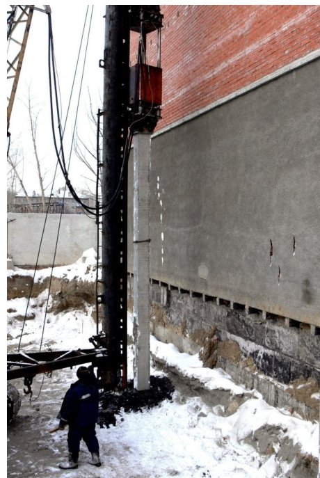
Рис. 2. Погружение свай гидравлическим молотом «РОПАТ» в непосредственной близости от существующего здания
