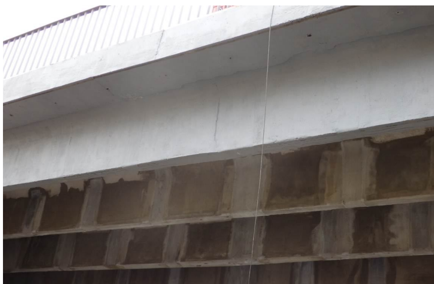
Рис. 2. Усиление балок холстами
