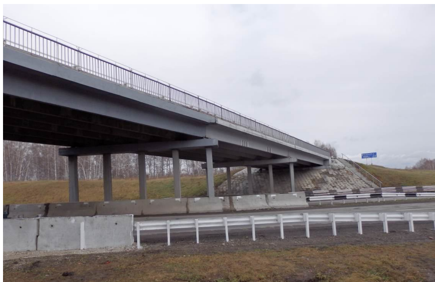
Рис. 1. Общий вид исследованного путепровода
