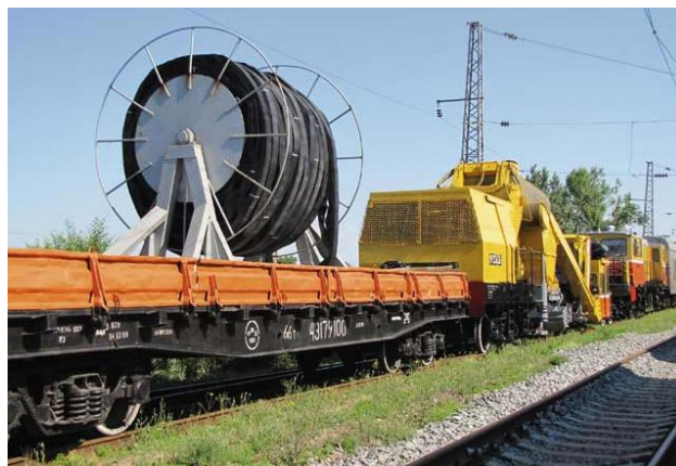
Рис. 2. Укладочный комплекс на базе машины СЧ-601
