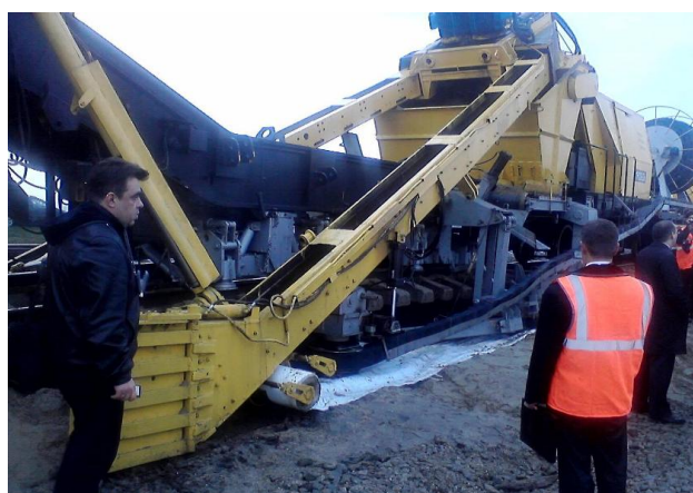
Рис. 3. Укладка геоматериалов комплексом на базе машины СЧ-601
