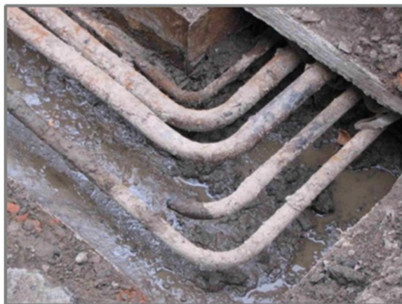
Рис. 1. Состояние трубопроводов со сроком службы более 21 года
