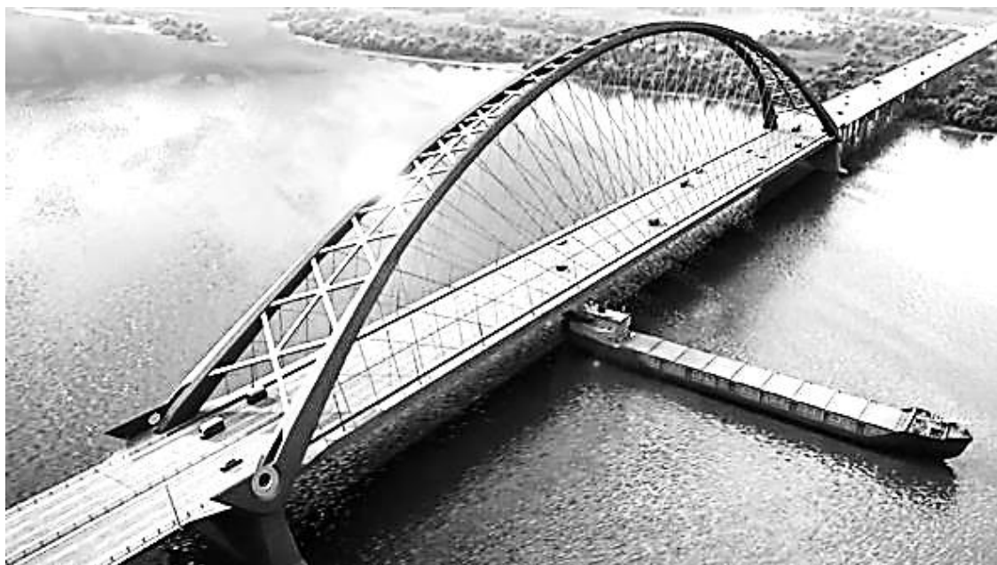
Рис. 1. Общий вид главного пролета Бугринского моста (г. Новосибирск)
