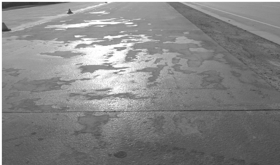
Рис. 7. Покрытие проезжей части автомобильной дороги в Новосибирской области в момент нанесения гидрофобизирующей пропитки
