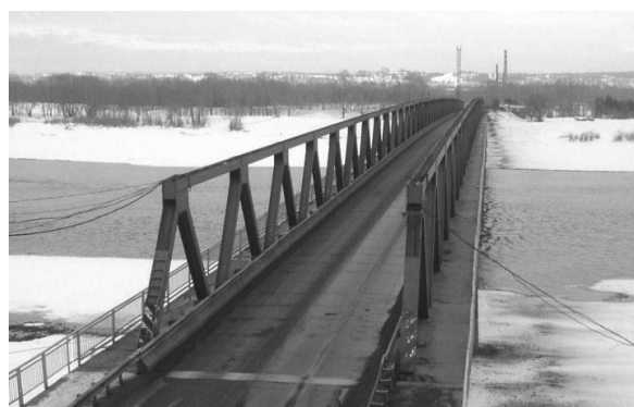
Рис. 1. Общий вид Байдаевского моста
