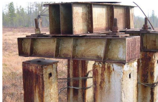
Рис. 2. Деформации фундаментов ВЛ: а – выпучивание; б – перекос
