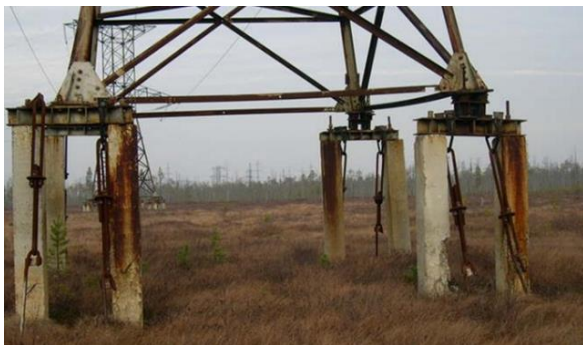
Рис. 2. Деформации фундаментов ВЛ: а – выпучивание; б – перекос
