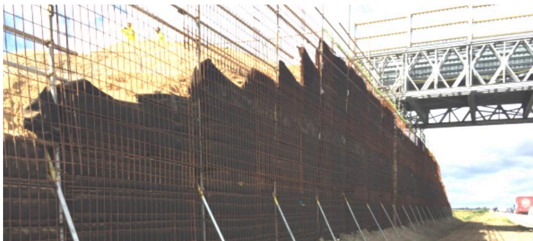
Рис. 7. Устой временного путепровода, Великобритания
