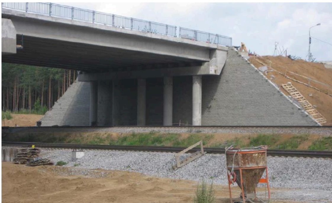
Рис. 2. Устой с раздельными функциями, Ленинградская область
