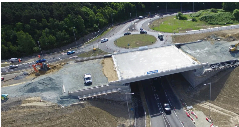
Рис. 5. Процесс строительства путепровода на А-21
