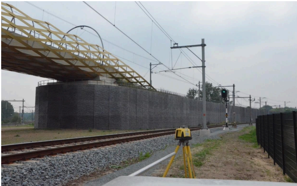
Рис. 6. Устой железнодорожного путепровода, Нидерланды
