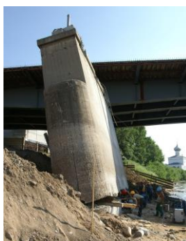
Рис. 4. Технология разрыва бетона по линии предварительно пробуренных отверстий с применением клиновых домкратов
