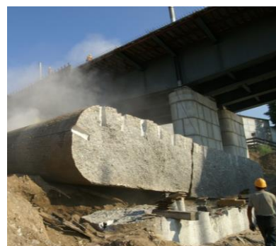
Рис. 4. Технология разрыва бетона по линии предварительно пробуренных отверстий с применением клиновых домкратов
