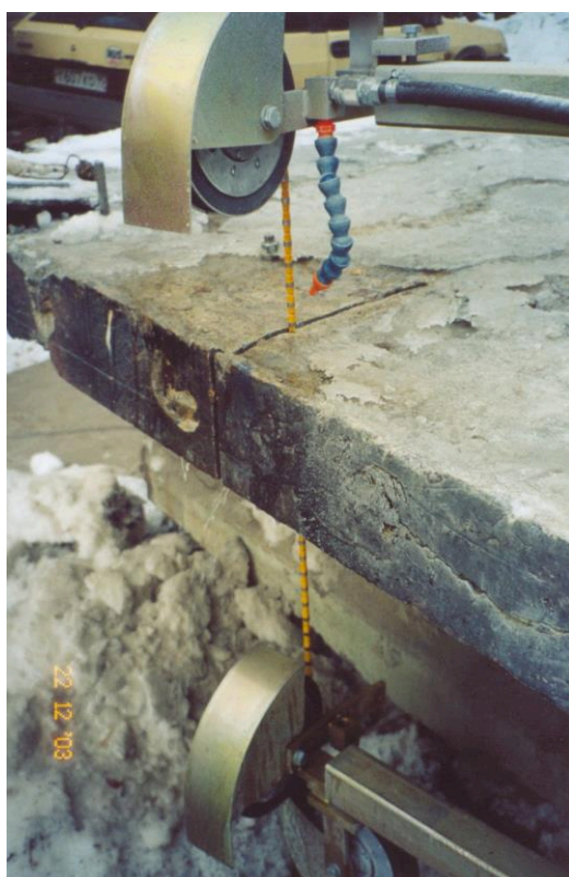
Рис. 3. Технология резания с использованием каната с алмазными сегментами цилиндрической формы
