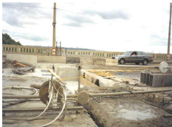
Рис. 5. Разборка надопорного узла пролетного строения Молитовского моста через р. Оку в Нижнем Новгороде при его реконструкции в 1998 г.
