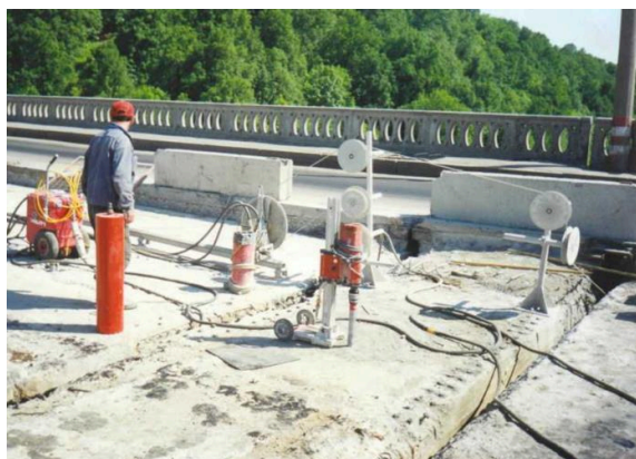
Рис. 5. Разборка надопорного узла пролетного строения Молитовского моста через р. Оку в Нижнем Новгороде при его реконструкции в 1998 г.
