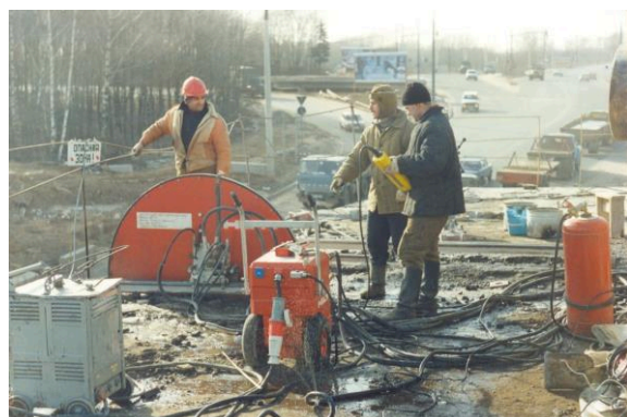
Рис. 1. Алмазная резка дисковыми пилами при реконструкции МКАД специалистами «НПП СК МОСТ»
