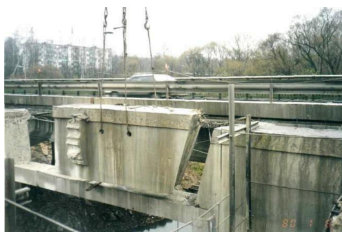
Рис. 6. Демонтаж путепровода типа «Бегущая лань» на автодороге М-8 «Холмогоры» в Ярославской области
