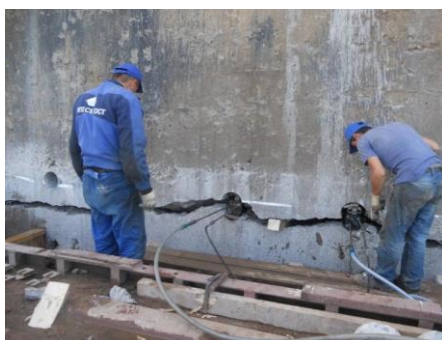
Рис. 4. Технология разрыва бетона по линии предварительно пробуренных отверстий с применением клиновых домкратов
