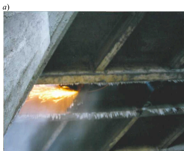
Рис. 1. Алмазная резка дисковыми пилами при реконструкции МКАД специалистами «НПП СК МОСТ»
