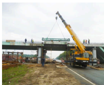
Рис. 6. Демонтаж путепровода типа «Бегущая лань» на автодороге М-8 «Холмогоры» в Ярославской области
