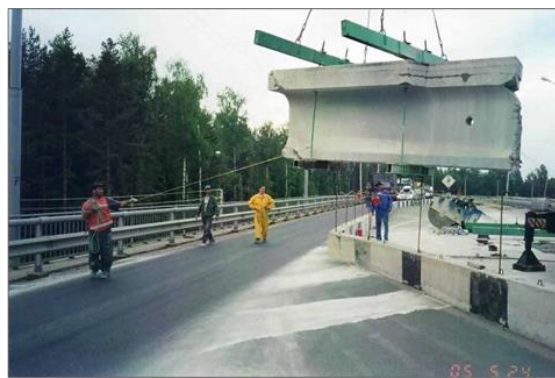
Рис. 8. Извлечение вырезанного элемента поврежденной балки с использованием траверса, путепровод на обходе г. Владимира (2004 г.)
