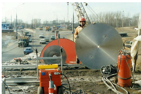
Рис. 1. Алмазная резка дисковыми пилами при реконструкции МКАД специалистами «НПП СК МОСТ»
